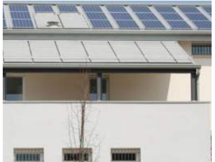
Yağmur Suyu İndirme
